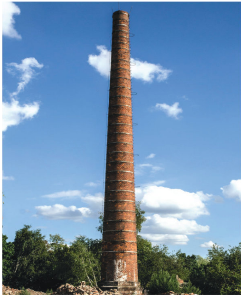
Původní komín koželužny určený k zachování (Zdroj fotografie: webový portál KAM HK)
